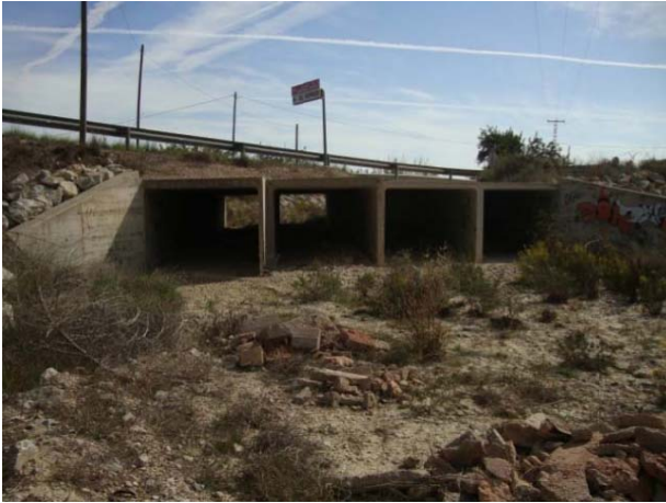
Figura 14: Construcciones para el desagüe de las ramblas al cruzarse con carreteras
