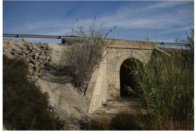
Figura 14: Construcciones para el desagüe de las ramblas al cruzarse con carreteras
